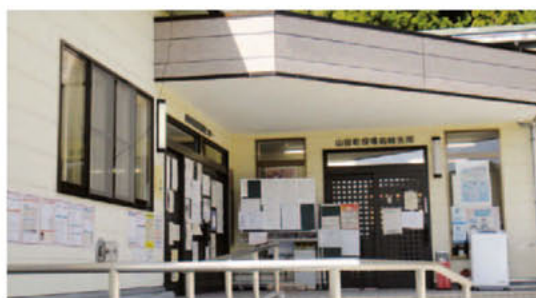
山田町の仮設庁舎
